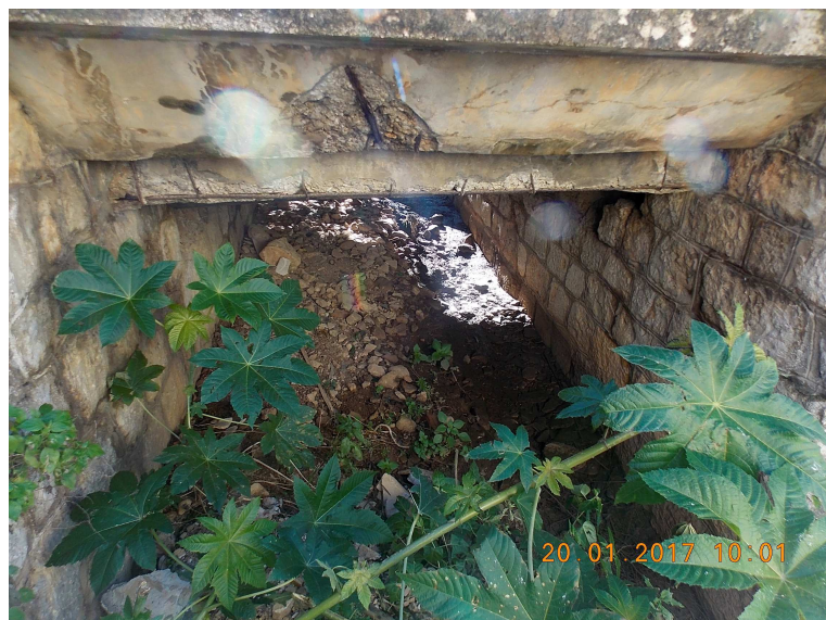
Fig. 5.2: Scatolare n.2 presente lungo la via dell'Ulivo. (1,20 m altezza x 2,00m larghezza)
