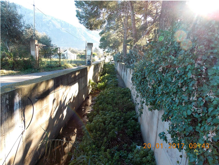
Fig. 5.1: Scatolare n. 1 presente lungo la S.S. 113. (1,20 m altezza x 2,00m larghezza)
