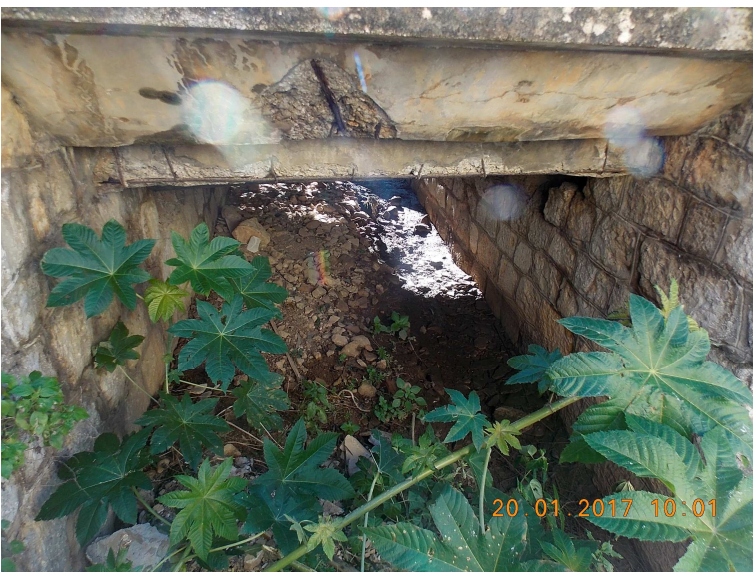
Fig. 5.2: Scatolare n.2 presente lungo la via dell'Ulivo. (1,20 m altezza x 2,00m larghezza)
